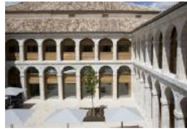
Vista exterior del Parador de Alcalá de Henares
